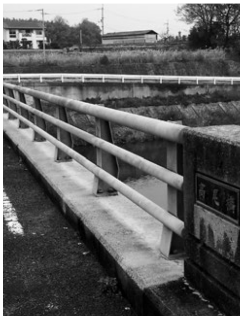
▲グループホーム建設予定地(池戸・高尾)
