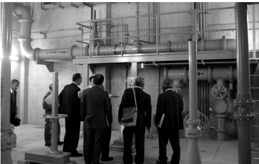
▲膜ろ過法先進地施設視察（島根県大田市浄化センター）
