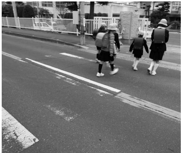
▲消えた横断歩道(平井小学校正門前)
