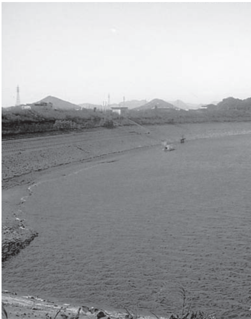
▲耐震診断が予定される男井間池(池戸)
