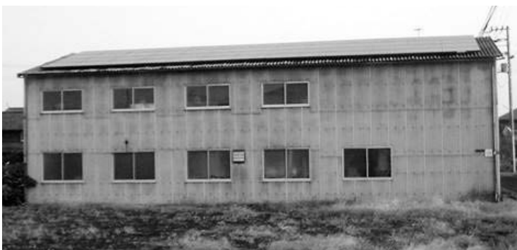
▲屋根に設置された太陽光発電
