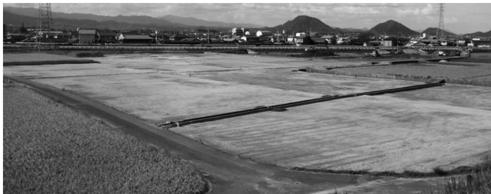
▲町公共用地維持管理工事により整地された処理場予定地
