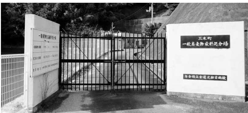
▲一般廃棄物最終処分場（津柳地区）
