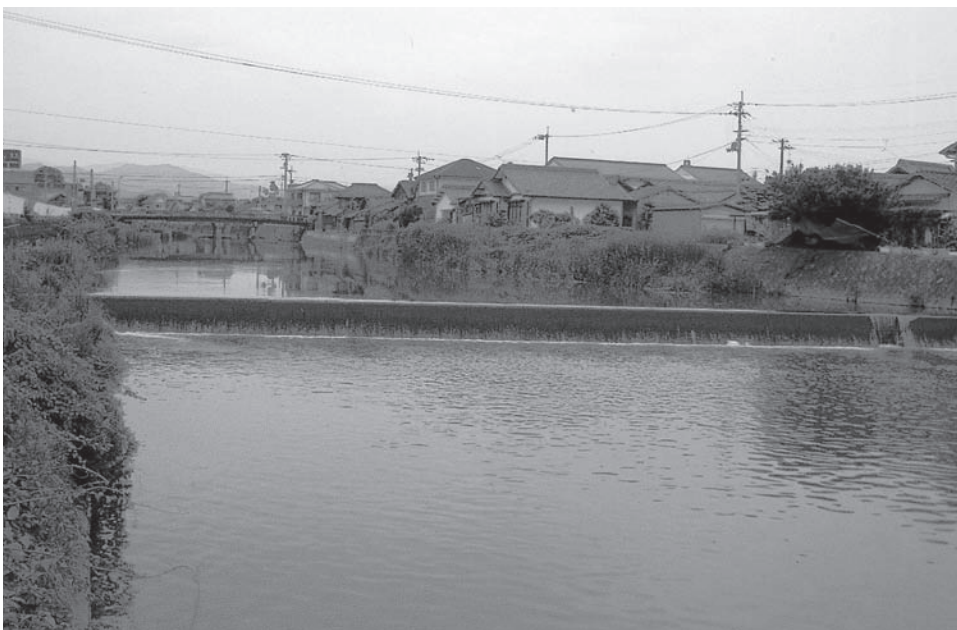
▲新川・琴電長尾線鉄橋より上流を望む(固定堰 住吉堰付近)
