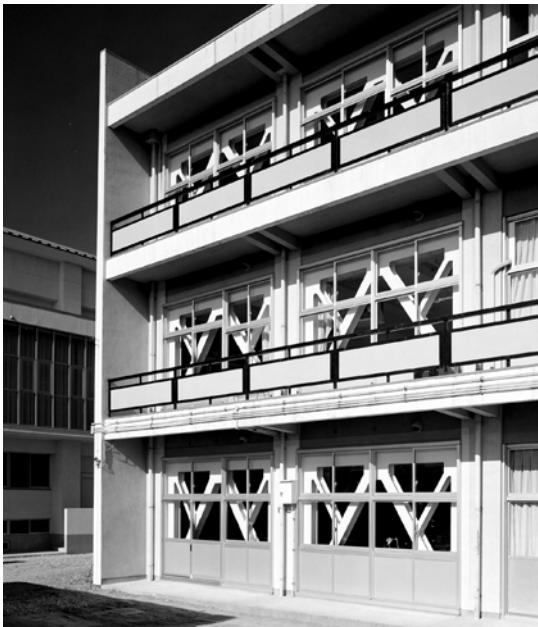
▲耐震化された三木中学校校舎
