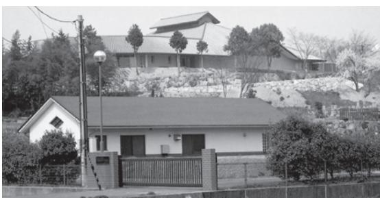
▲井上北部浄化センター
