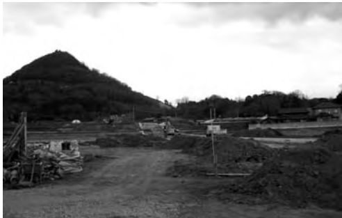
▲工事が進む町道正一駒足線
