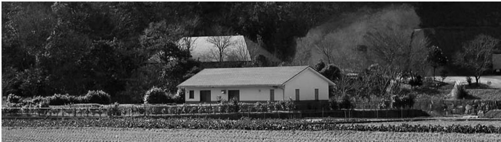
▲現在稼働中の井上北部処理場
