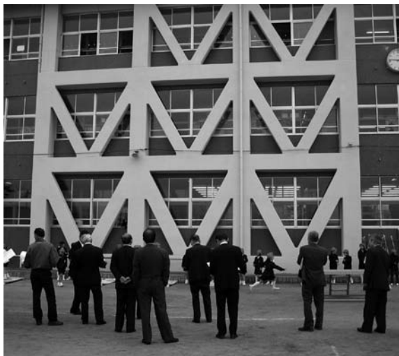
▲耐震工事が完了した氷上小学校北棟
