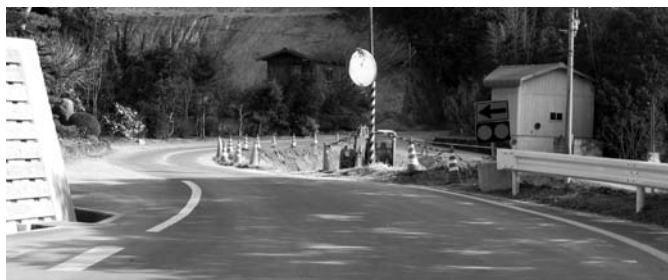
▲拡幅中の町道三条鹿庭線
