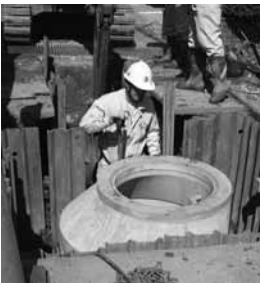
▲公共下水道管路工事(池戸地区)
