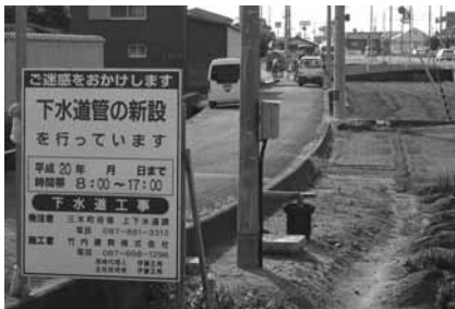
▲三木東地区管路工事(下高岡地区)
