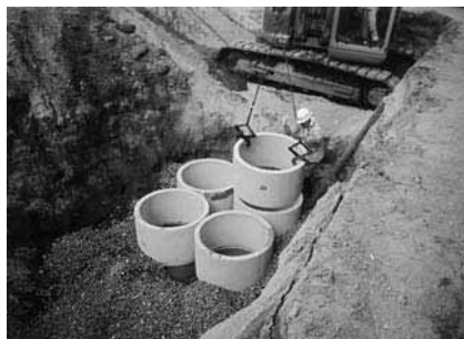
緊急井戸掘工事
