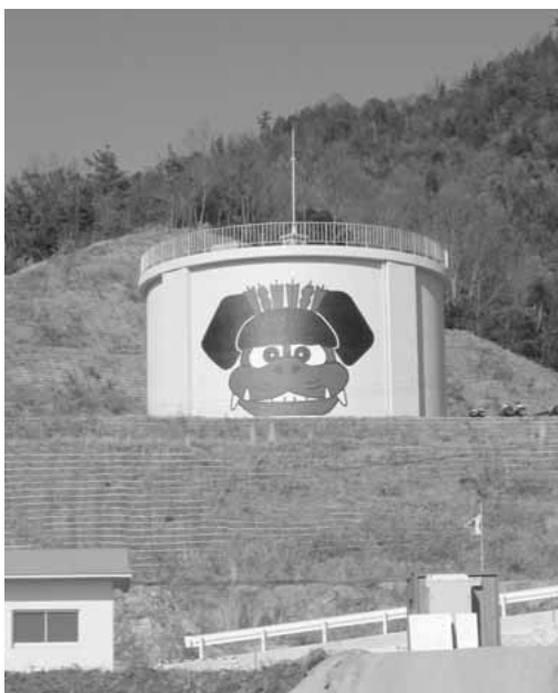
完成間近の池戸配水池
