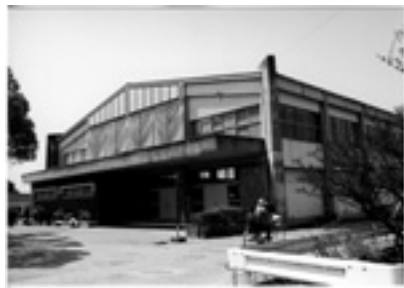
▲三木中学校体育館
