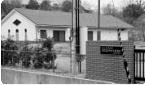
▲接続率アップが急がれる井上北部地区
