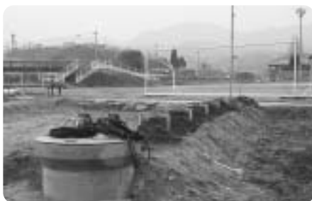
▲取水工事が進む西サッカー場
