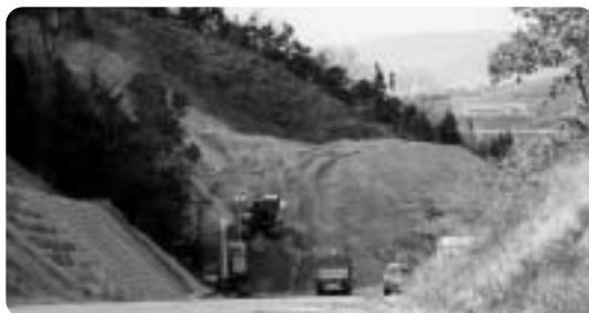
▲工事が進む三木志度線
