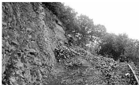
▲急がれる安全対策
